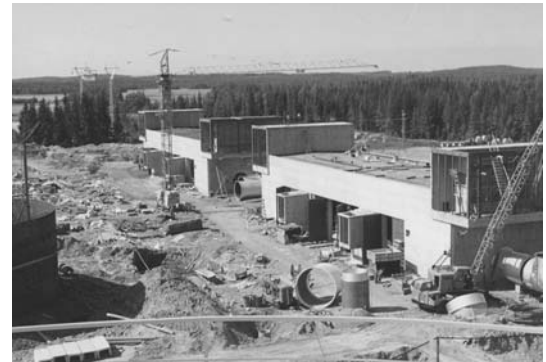
Imatran Voiman Oy:n Huutokosken voimalaitoksen rakennustyömaa vuonna 1974.
