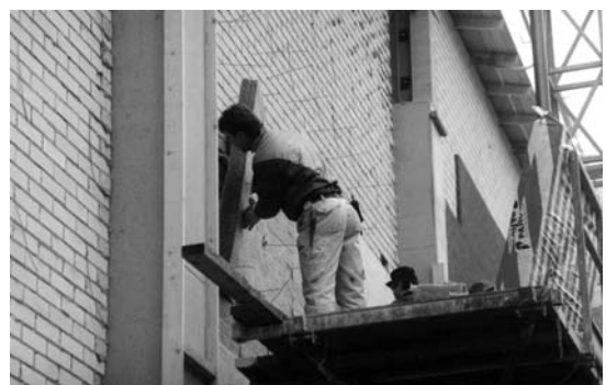
Muurarin työhön kuuluu tänä päivänä myös seinien eristäminen.
