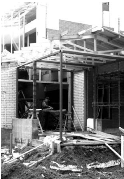
Liikuntahallin sisäänkäynti alkaa hahmottua.
