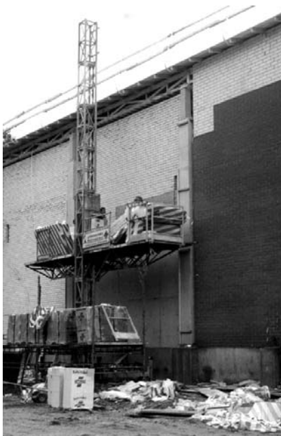
Hydrauliset telineet helpottavat muurarien työskentelyä korkeissa paikoissa.
