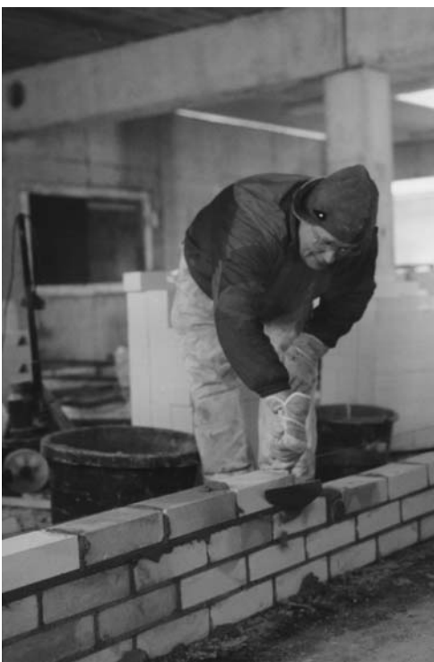
Pakkasmittari näyttää kolmeatoista astetta, mutta rakennustöiden täytyy edistyä.
