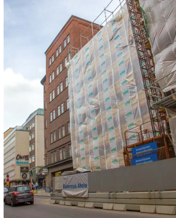
As Oy Nahkakeskustalo sijaitsee vilkasliikenteisessä Fredrikinkadun ja Kalevankadun risteyskässä, mikä asettaa jo muutenkin vaativaan peruskorjaukseen omat haasteensa. Fredrikinkadun puolella vuonna 1882 valmistuneessa nelikerroksisessa talossa rakennustöitä tehdään sääsuojan uumenissa. Osa tealueesta on saatu työmaan käyttöön.
