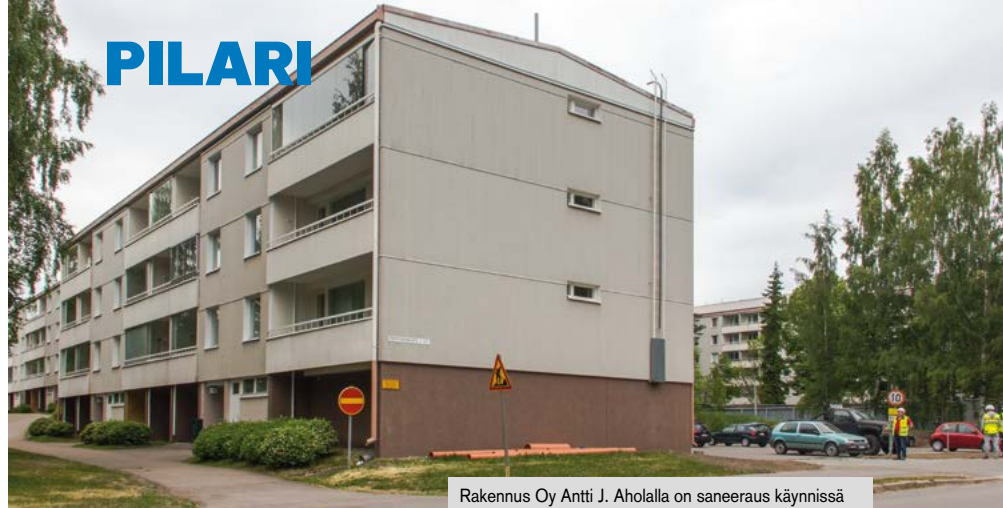
Rakennus Oy Antti J. Aholalla on saneeraus käynnissä Lahden suurimmassa yksityisessä taloyhtiössä, As Oy Mikkulan Cityssä.
