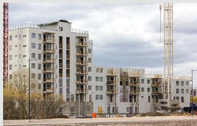
Majurinkatu 3:n kolmesta rapusta koostuva kokonaisuus valmistuu. B- ja C-rapun rakennustyöt ovat ehtineet viidennen kerroksen korkeudelle. Päätyrakennus on saavuttanut harjakorkeutensa.
