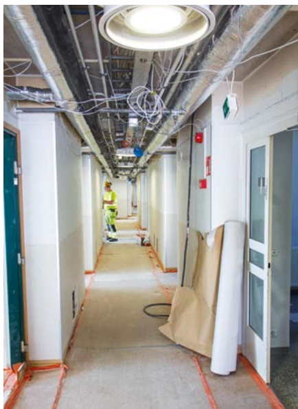
Peruskorjaustyöt edistyvät hotellin käytävillä
