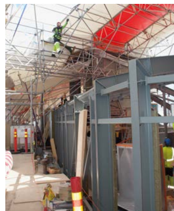
Katolla tehdään konehuoneita
