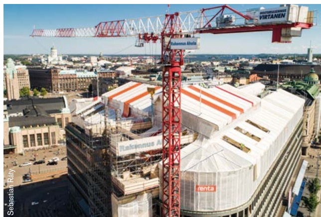
Rakennustyöt edistyvät huppujen alla
