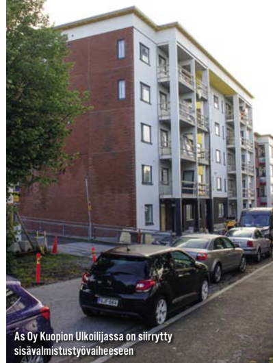
Lipa-Betonin elementtejä: maanpaineseinää, parveke-elementti sekä tiilipintainen, harmaaksi maalattu sekä paikalla rapattu villapintainen sandwich-elementti
