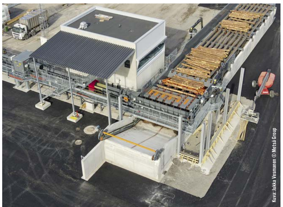
Kuvassa Metsä Fibren sahan tukkien vastaanottorakennus, jossa on käytetty Lipa-Betonin hybridielementtejä.
