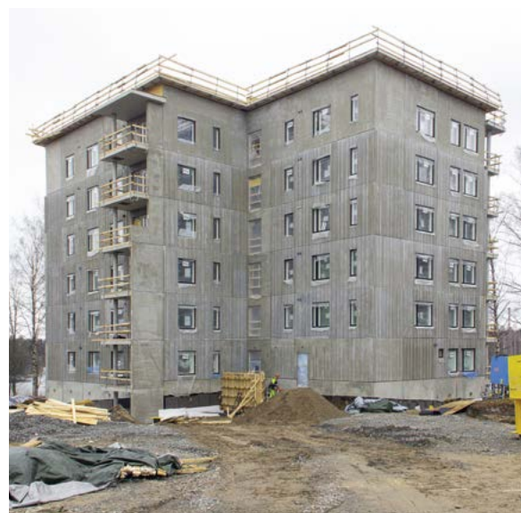
As Oy Siilinjärven Valkamanrannassa elementit ovat paikoillaan ja sisävalmistus on täydessä käynnissä
