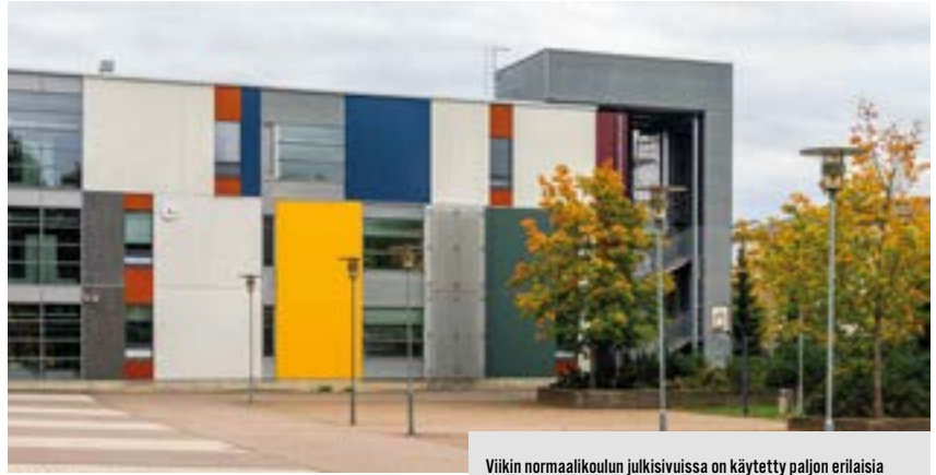
Viikin normaalikoulun julkisivuissa on käytetty paljon erilaisia materiaaleja ja värejä. Ulkovaorauksessa on valkeita, mustia ja värjättyjä betonielementtejä, vanerilevyjä, ohutrapattua ja paikalla muurattua tiilipintaa sekä kasetti- ja aaltopeltiä.
