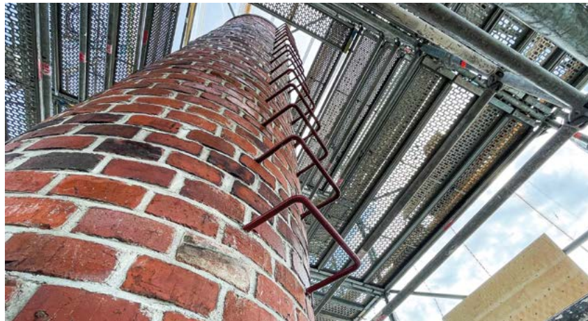
Kuva: Rakennus Oy Antti J. Ahola
